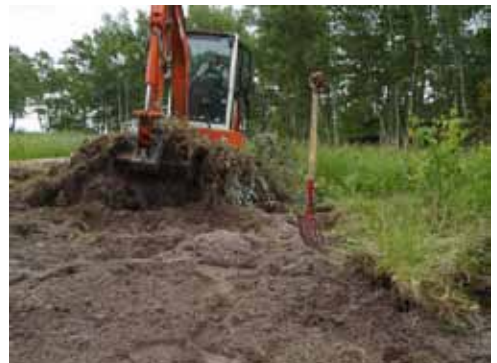
Afskrælning med maskine kan anbefales, hvis det er større partier det drejer sig om.
